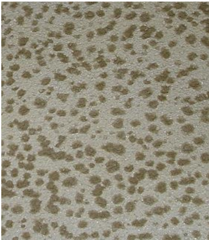
Figure 19 : Altération précoce d'un revêtement minéral récent.
