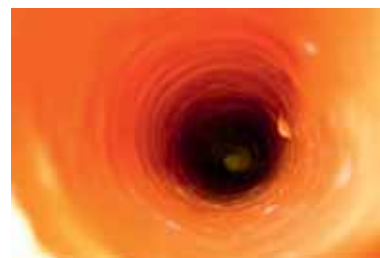
Problematische Oberflächen nach einer Rohrrinnensanierung mit Epoxidharz.
