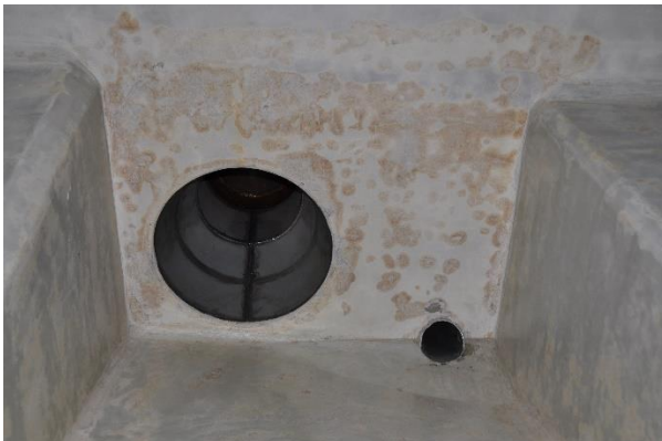
Abbildung 23 Typisches Beispiel für die Fleckenbildung in einer Wasserkammer
