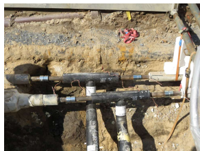
Nachträglicher Einbau von Absperrarmaturen und Abzweigen
