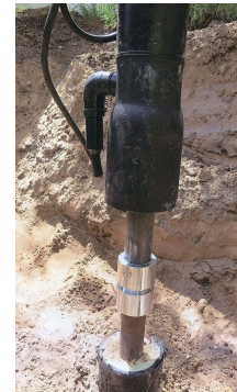
Auswechslung von Erdarmaturen Belüftung / Entleerungen
