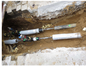
Nachträglicher Einbau von Absperrarmaturen und Abzweigen
