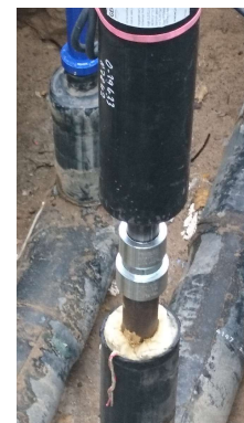
Auswechslung von Erdarmaturen Belüftung / Entleerungen
