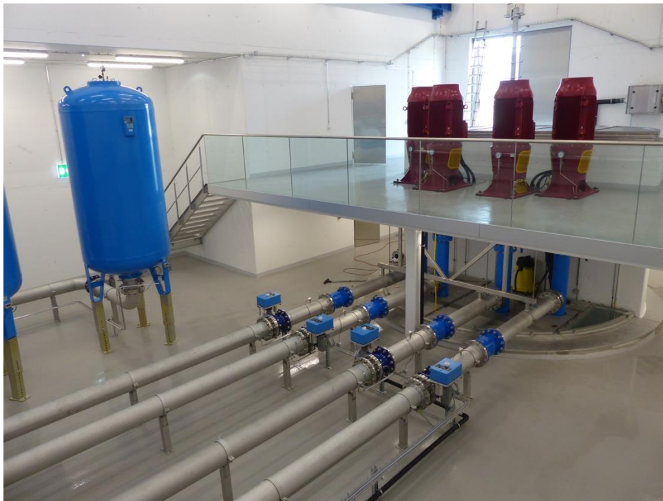
Abbildung 66 Komponenten in einem Pumpsystem
