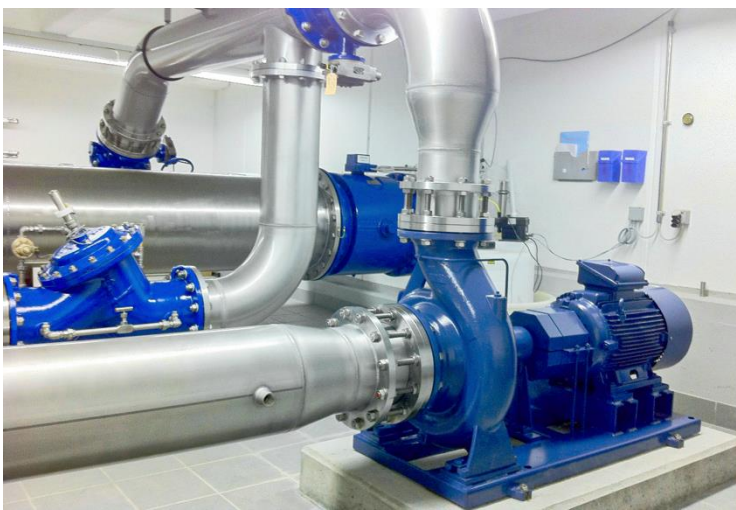
Abbildung 51 Pumpe als Turbine PAT
