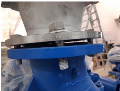
Abbildung 91 Nicht zulässige Klaffung und Parallelversatz von Anschlussflanschen
