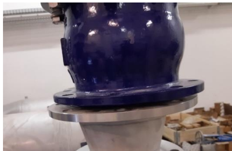
Abbildung 91 Nicht zulässige Klaffung und Parallelversatz von Anschlussflanschen
