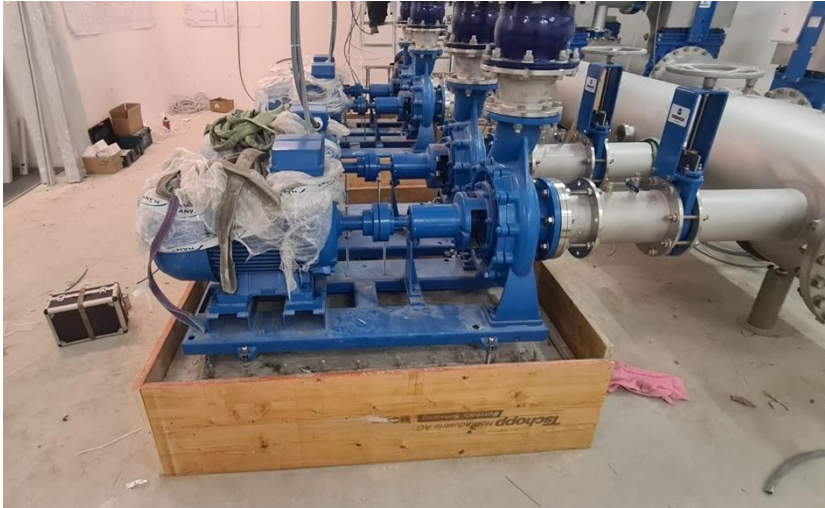
Abbildung 92 Schalung zum Ausgießen des Fundaments
