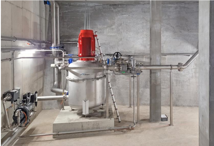
Abbildung 50 Gegendruckpeltonturbine GDPT
