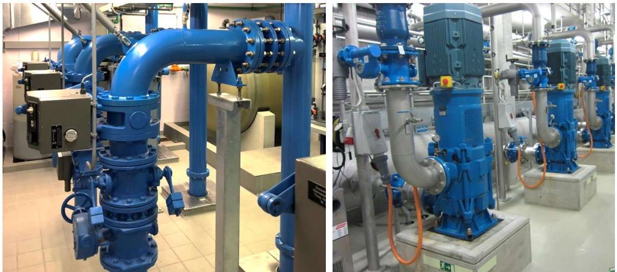
Abbildung 98 Beispiele von eingesetzten Drosselklappen
