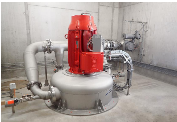
Abbildung 49 Peltonturbine PT, vertikale Aufstellung
