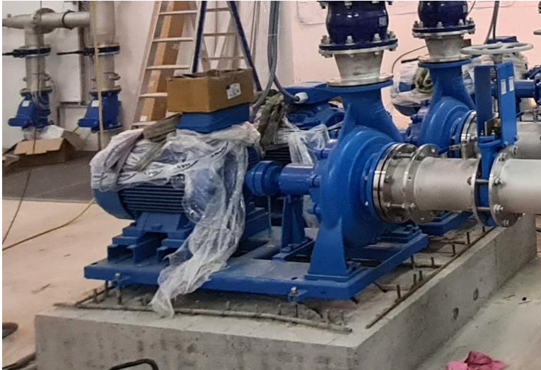
Abbildung 90 Pumpenaggregat auf Klebeanker vormontiert
