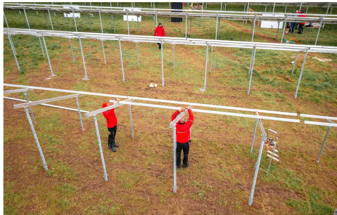
Vue générale de la structure vissée
