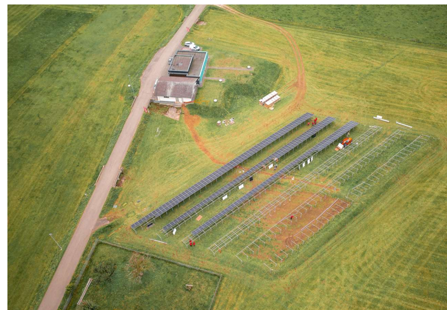
Vue générale de l'implantation
